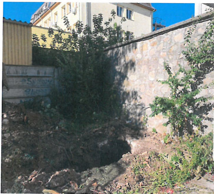
Foto nr. 9 – Sondaj la fundație zid de sprijin
