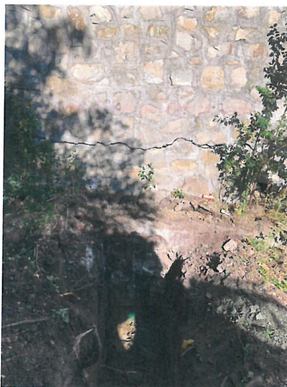
Foto nr. 10 – Sondaj la fundație zid de sprijin
