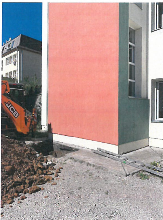
Foto nr. 7 – Sondaj fundații – casa scării corp E
