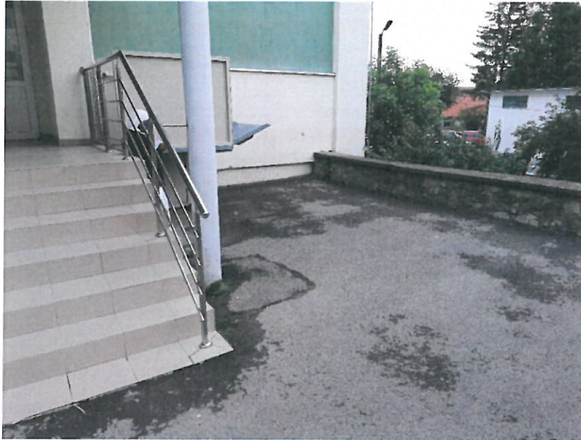
Foto nr. 3 – Aspect zonă acces corp E – parte superioară zid de sprijin
