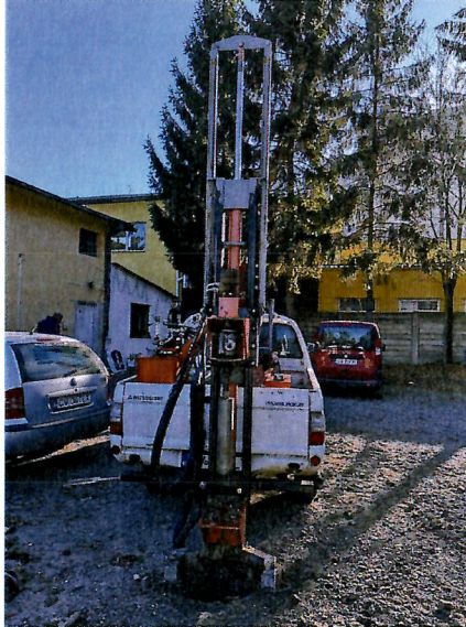
Foto.1: Aspectul terenului investigat și instalația de foraj geotehnic Pride Mount 20
