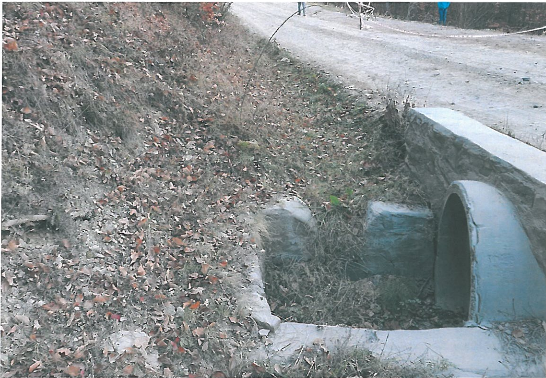
Foto 2: Vedere amonte podet, camera de cadere
