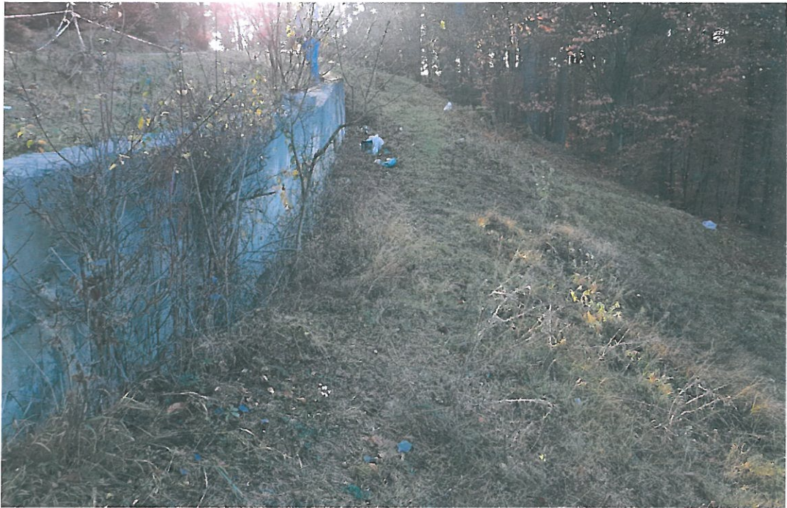
Foto 5: Vedere zid de sprijin rambleu
