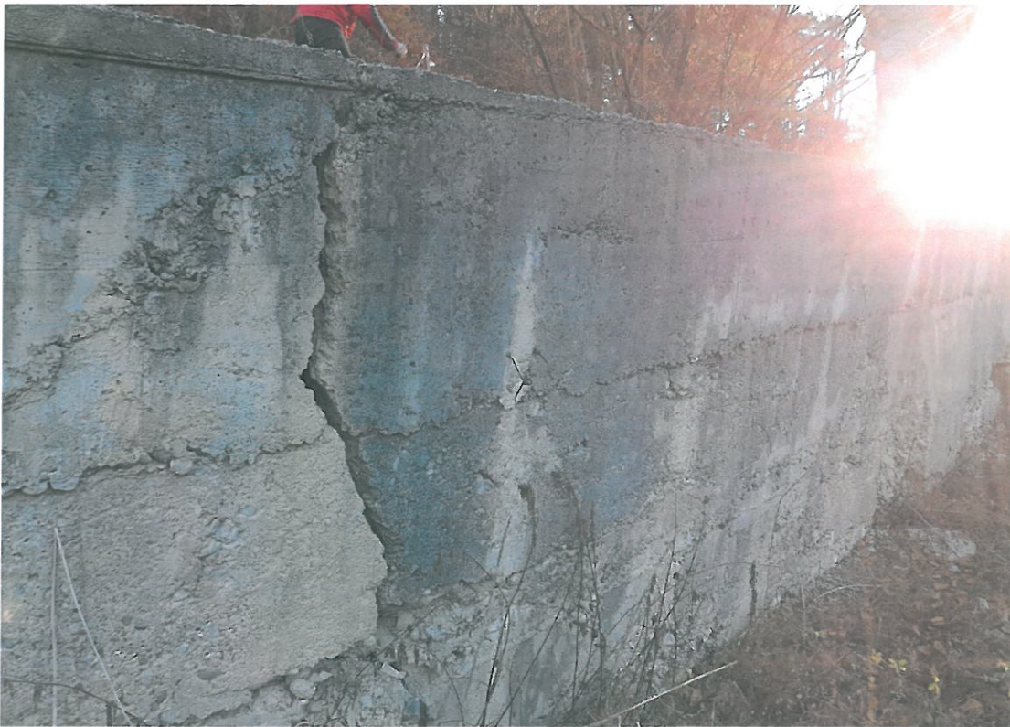
Foto 6: Aspect beton zid de sprijin rambleu
